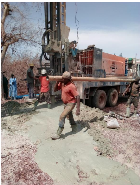
Début du forage à Boudinghin
