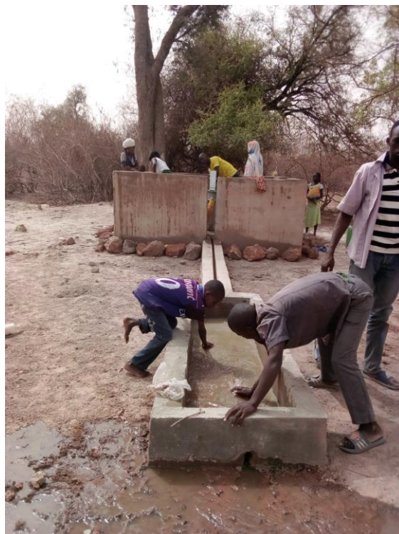
La pompe installée à Boudinghin
